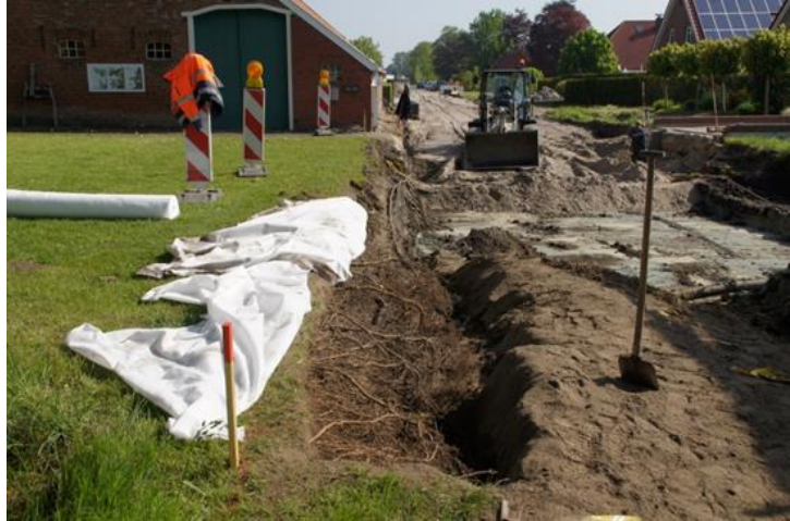
Baustelle an der K 63
